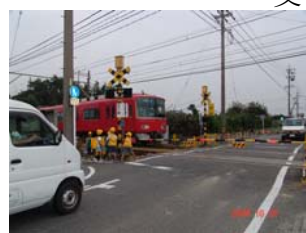
拡幅整備されることになった四畝踏切と東側歩道部分
